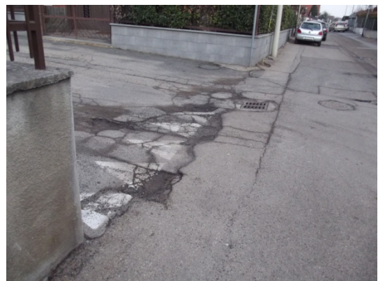
Esempio di traversa con fondo degradato
