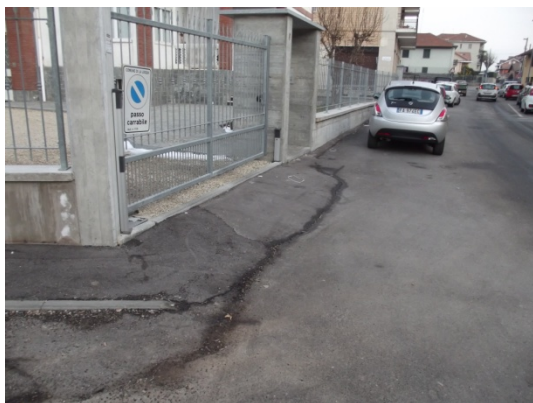
Passo carraio con manto bituminoso sconnesso
